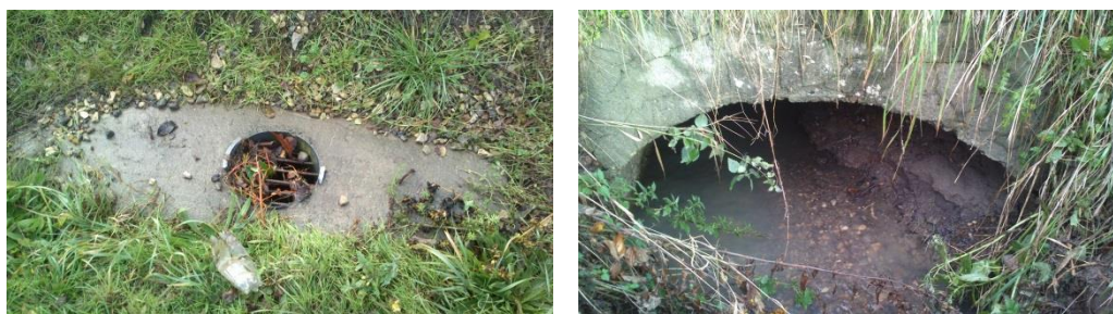
Figur 6.2. Ind- og udløb ved tidligere underføring under Holmgårdvej.
